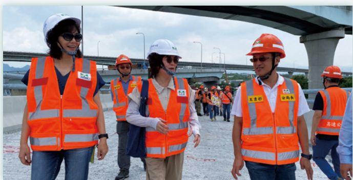
▲交通部高速公路局第一新建工程分局分局長王吉杉（右）說明施工進度及改善重點。
